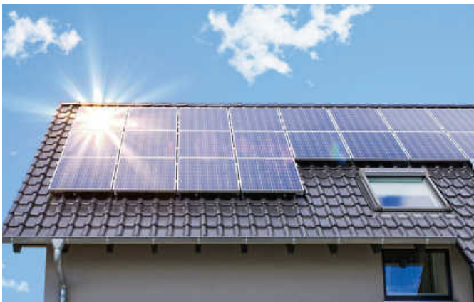
Gemeinsam mit der Gemeinde Hochdorf und den Teckwerken plant die Stadt Ebersbach an der Fils eine Photovoltaik Bündelaktion.
