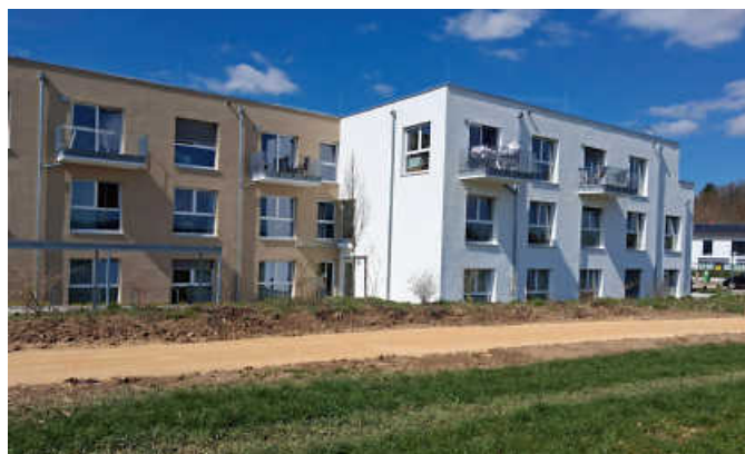
Der neue Weg am Pflegestift in Roßwälden wurde rechtzeitig zum Frühling fertig
