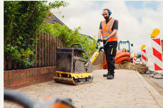
Nach Glasfaser-Ausbauarbeiten Wiederherstellung Ursprungszustand
