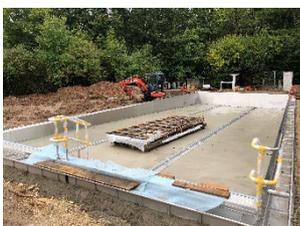
**Bildunterschrift:** Im Rahmen der Bauarbeiten erhält das Nichtschwimmerbecken eine Edelstahlauskleidung, die inzwischen fast fertiggestellt ist.
